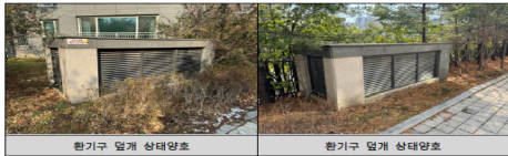
환기구 덮개 상태양호
